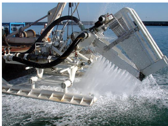
Figure 60 : Exemple de water jetting
