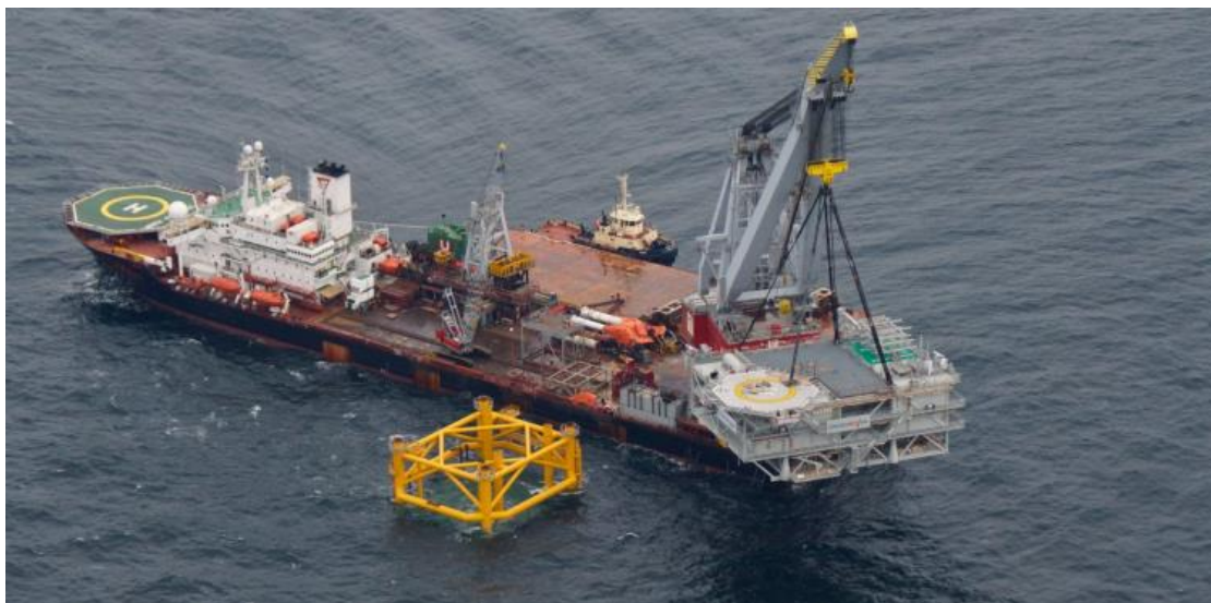
Figure 34 : Installation d'une sous-station (source DONG Energy).
