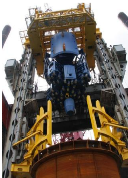
Figure 33 : Tête de forage et guide (source DONG Energy).
