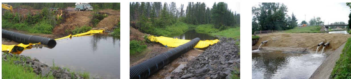
Figure 75 : Exemples de batardeaux provisoires
