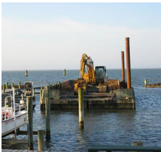
Figure 62 : Exemple de pelle mécanique sur barge autoélevatrice
