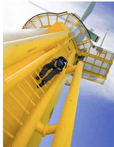
Figure 82 : Accès à la turbine par la pièce de transition (source DONG Energy).
