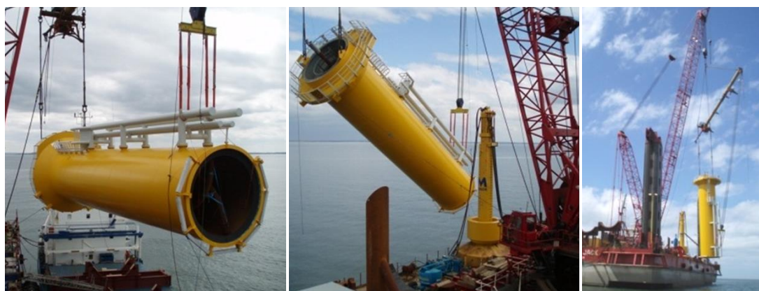
Figure 37 : Mise à l'eau de la pièce de transition (source DONG Energy).
