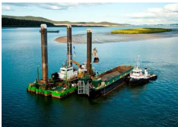
Figure 61 : Exemple de pelle rétro-caveuse, ici avec navire sablier et remorqueur
