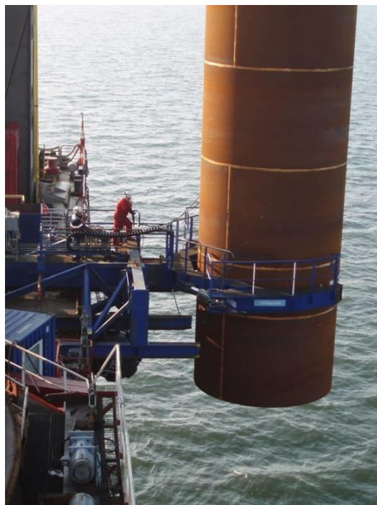
Figure 36 : Descente du monopieu dans son guide (source DONG Energy).
