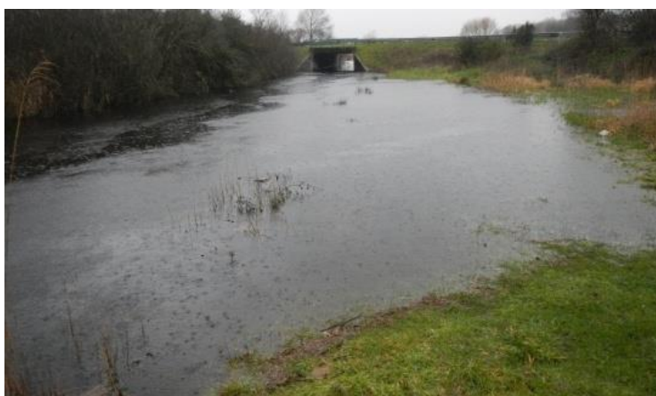
Figure 12 : Canal de La Taillée (cliché TBM)
