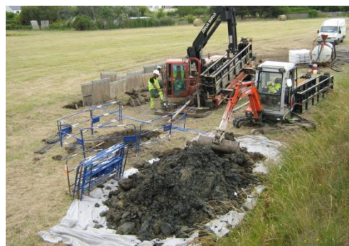
Figure 72 : Exemple d'un forage dirigé 4 trous ou 1 trou (suivant répartition des fourreaux)
