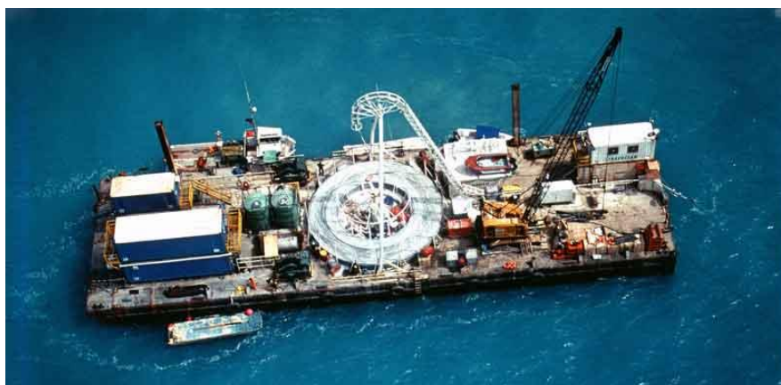
Figure 64 : Exemple d'une barge de pose
