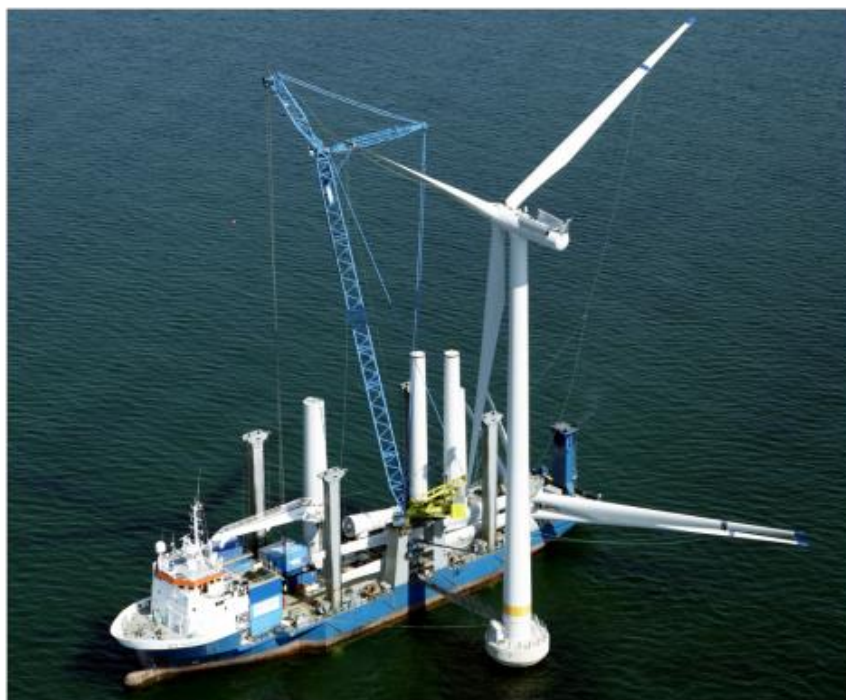
Figure 42 : Navire d'installation après montage d'un aérogénérateur (source A2SEA).
