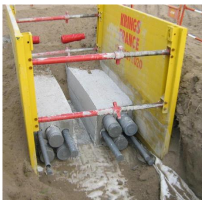
Figure 69 : Illustration d'une liaison souterraine à deux circuits
