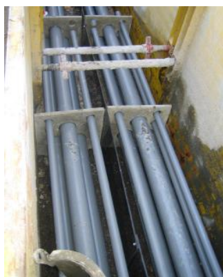
Figure 69 : Illustration d'une liaison souterraine à deux circuits
