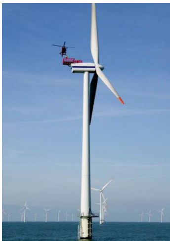
Figure 81 : Hélicoptère sur le site d'Horns Rev (source DONG Energy).
