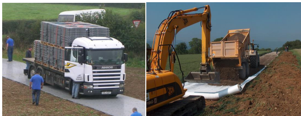
Figure 77 : Exemples de pistes en « plaques » et en matériaux
