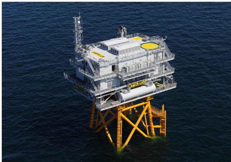
Figure 16 : Sous-station du parc éolien de Walney (source DONG Energy).
